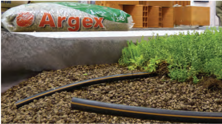
Aplicación de la arcilla expandida Argex en cubiertas ajardinadas
