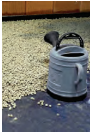
Aplicación de la arcilla expandida Argex en cubiertas ajardinadas
